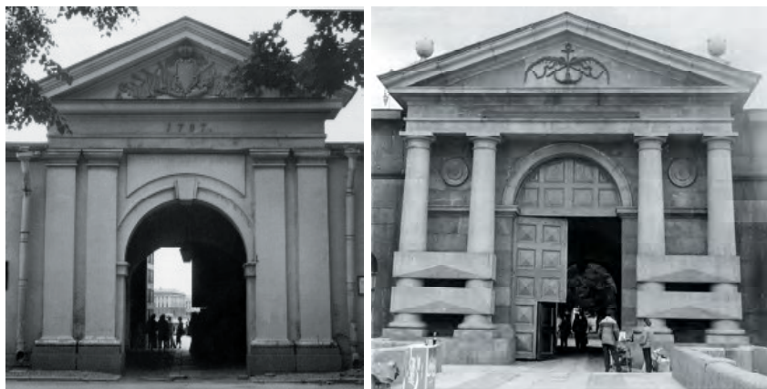
Северный и южный фасады Невских ворот. Фотографии. 1993 г.
