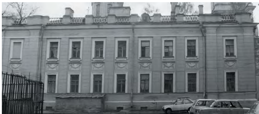
Северный фасад Церковного дома. Фотография. 1995 г.
